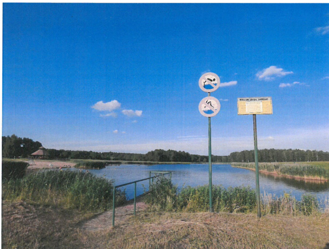
Fot. 3 Oznakowanie przy przepuście z zastawką na zbiorniku rekreacyjno – retencyjnym w Zarzeczanach, fotografia Urzędu Gminy Gródek.
